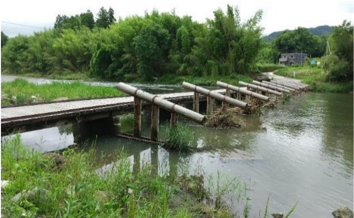
久野瀬橋（斜めの柱がゴミ受け）
