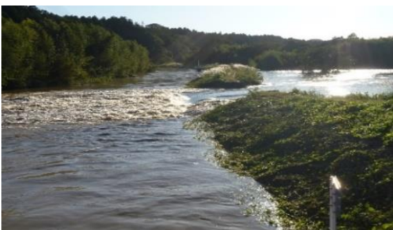
堤防が決壊した藤井川
